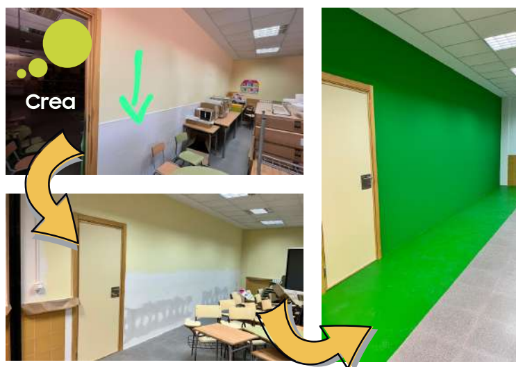
ZONA CREA: Retirada de baldosas y pintura verde Chroma.
